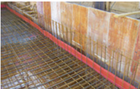
KRASO® Fugenband Duo-Fix 150 „plus“ Aufstellen auf der oberen Bewehrungslage
